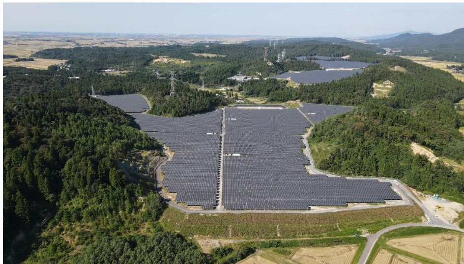
<大日メガソーラー発電所 全景写真>
