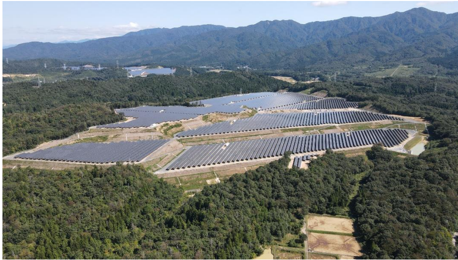
<大室メガソーラー発電所 全景写真>
